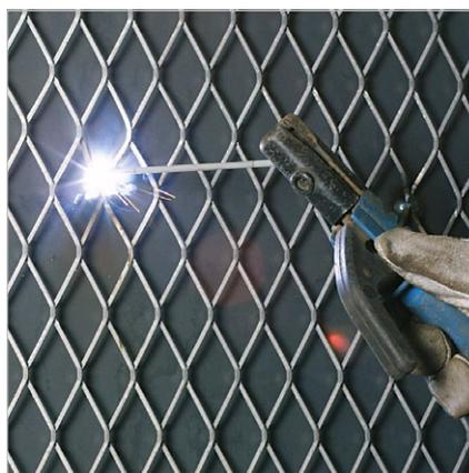
Приварка ромбовидной сетки: расстояние между точками крепления составляет порядка 250 мм
