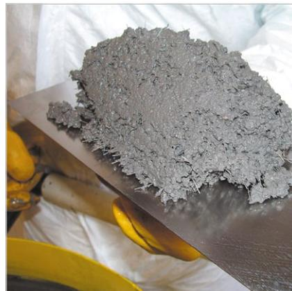
6. Полученная твёрдо-пластичная смесь KALCRET наносится с помощью обычного мастерка
