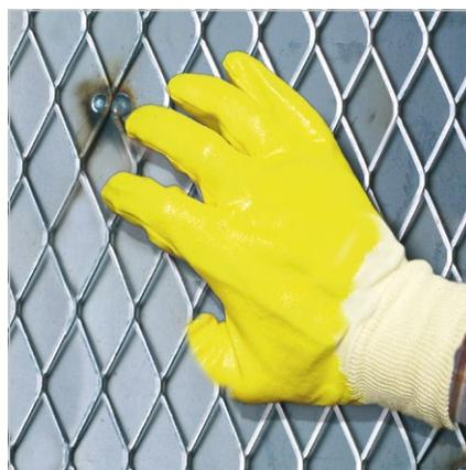
Жесткое крепление — расстояние до футеруемой поверхности примерно 5 мм
