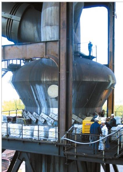
Технология механического нанесения материала обеспечивает быструю и надежную защиту. На фотографии показан момент футеровки циклона на сталелитейном заводе с использованием износостойкого материала KALCRET.
