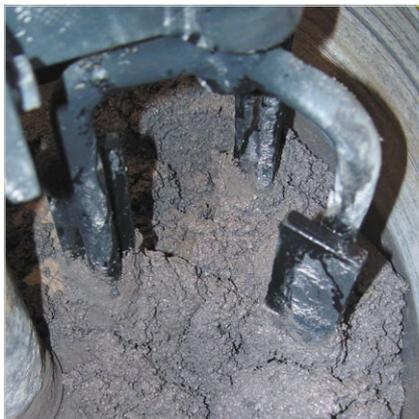
5. Полученная смесь должна иметь пластичную или твёрдо-пластичную консистенцию
