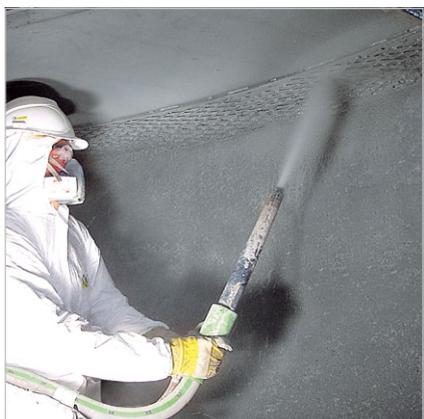
Простое выполнение работ на потолочных поверхностях
