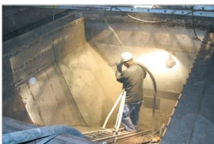
Футеровка вакуум-камеры на металлургическом заводе под транспортером для спека
