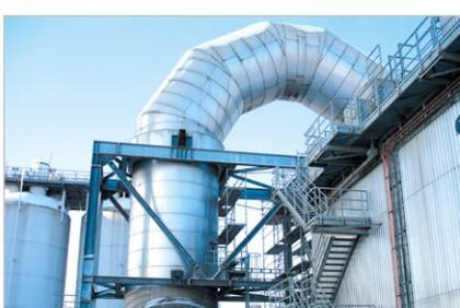
Трубопровод для транспортировки клинкерной пыли на цементном заводе
