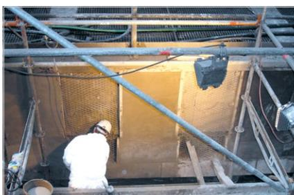
Футеровка отбойной плиты рампы выгрузки кокса
