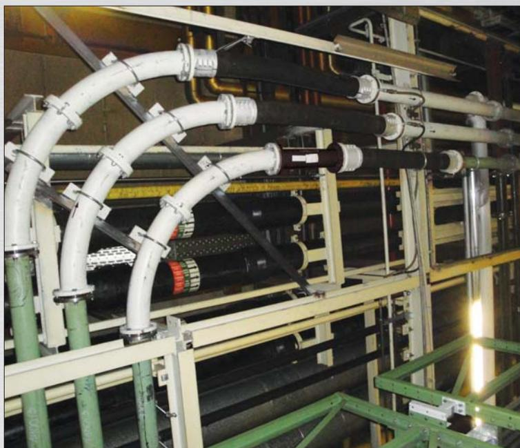
В системах пневматической транспортировки, где невозможно определить точные размеры труб и изгибов, можно использовать гибкие резиновые трубки с керамической футеровкой. Соединение керамической футеровки выполняется по типу «папа-мама», что делает резиновые трубки более гибкими и позволяет им изгибаться в любом направлении.
